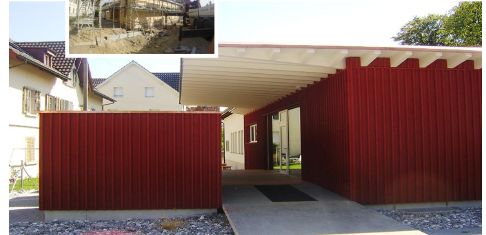
Der Kindergarten Sonnenwinkel, immer ungefähr vom gleichen Standort aus gesehen – vor, während und nach dem Umbau
