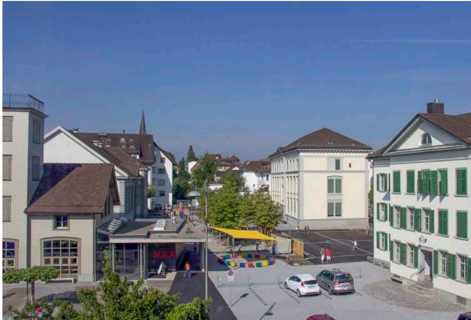
Soll bald eine neue Heizung und Photovoltaik-Anlagen bekommen: Das Schulareal mit Rebsamen- und Oberschulhaus (rechts von vorne) sowie Aula und Alte Turnhalle (links von vorne)
